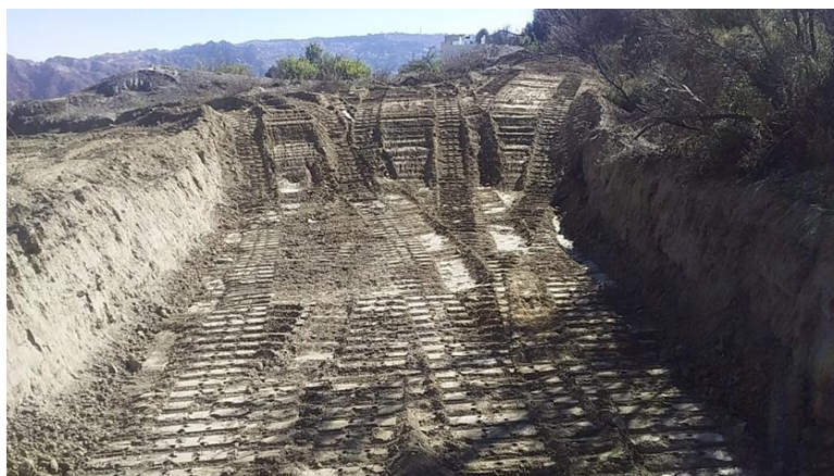
Figura 3.8. Excavación de reservorio en la cabecera de Diseños Experimentales
