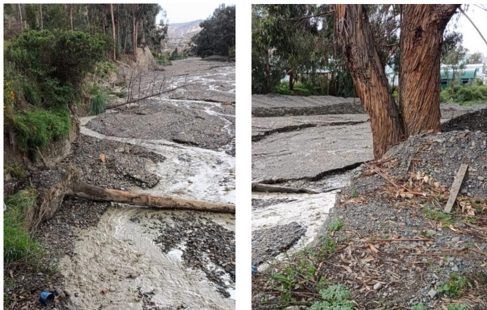
Figura 5.1. Deslizamiento de plataforma e inminente colapso de árbol de eucalipto.
