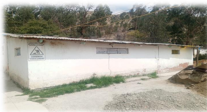
Figura 4.2. Condiciones deterioradas en la parte inferior de los muros sin sócalo
