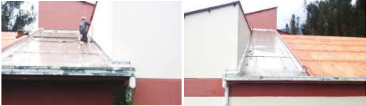
Impermeabilización con membrana asfáltica, aulas Cota Cota
