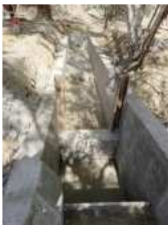
Construcción de cámaras desarenadoras para tratamiento físico
