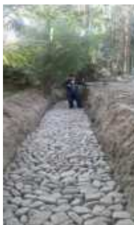
Construcción de cámaras desarenadoras para tratamiento físico
