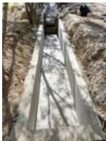
Construcción de cámaras desarenadoras para tratamiento físico
