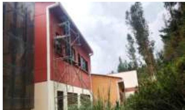
Cambio de alero fachada posterior
