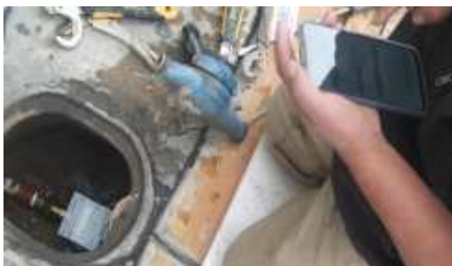
Cambio de medidor de agua poptable (personal de epsas)
