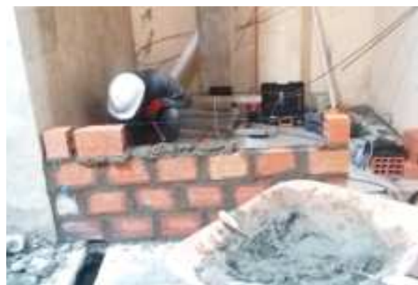
Muro de ladrillo y conexión sanitaria
