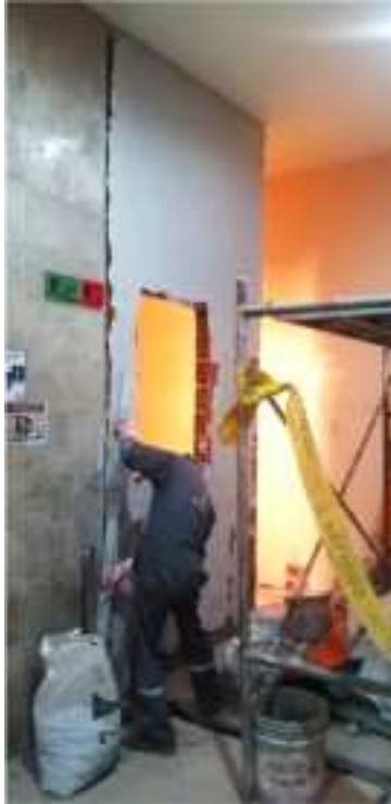
Revoque de yeso sobre ladrillo
